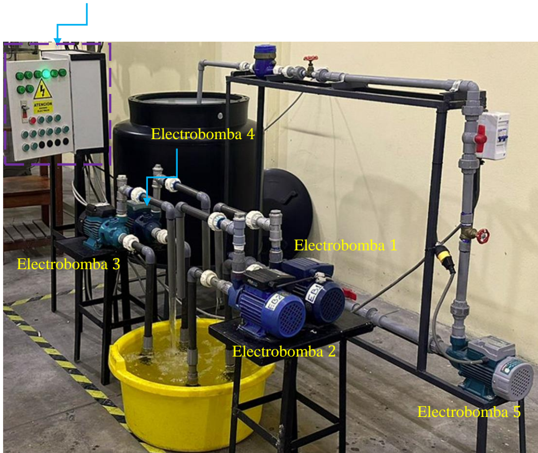
Figura A1. Vista real del sistema de automatización, después de su instalación en los dos equipos del Laboratorio de Operaciones y Procesos Unitarios de la FIQ-UNAP.
