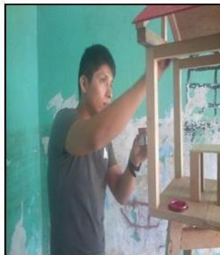
Imagen N° 05. Pintado de la caseta estación N° 3. Construcción.
