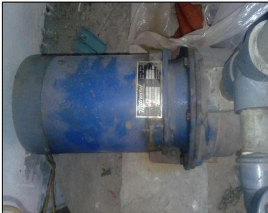
Electrobomba de tipo centrifuga de marca Hidrostal de capacidad 1.0 HP.
