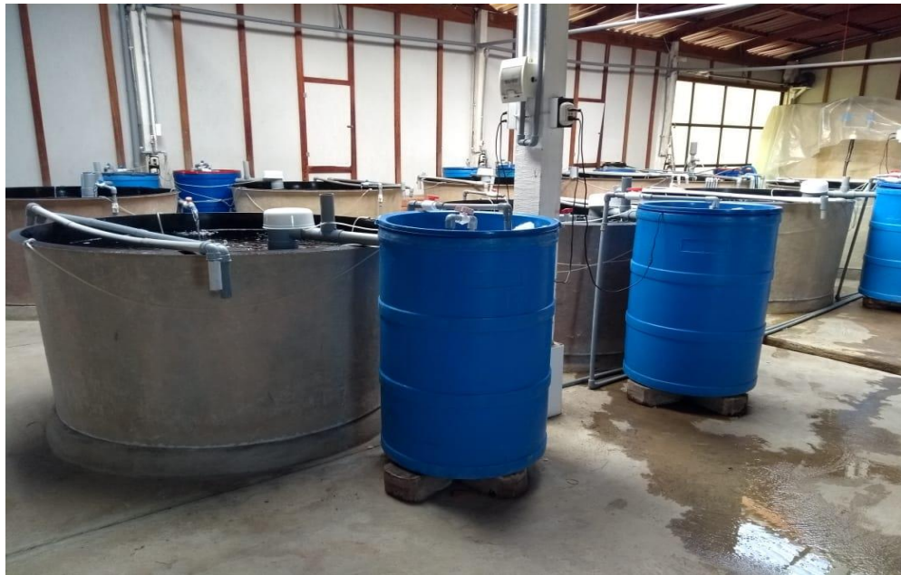
Ilustración 3: Tanques circulares y filtros biológicos.
