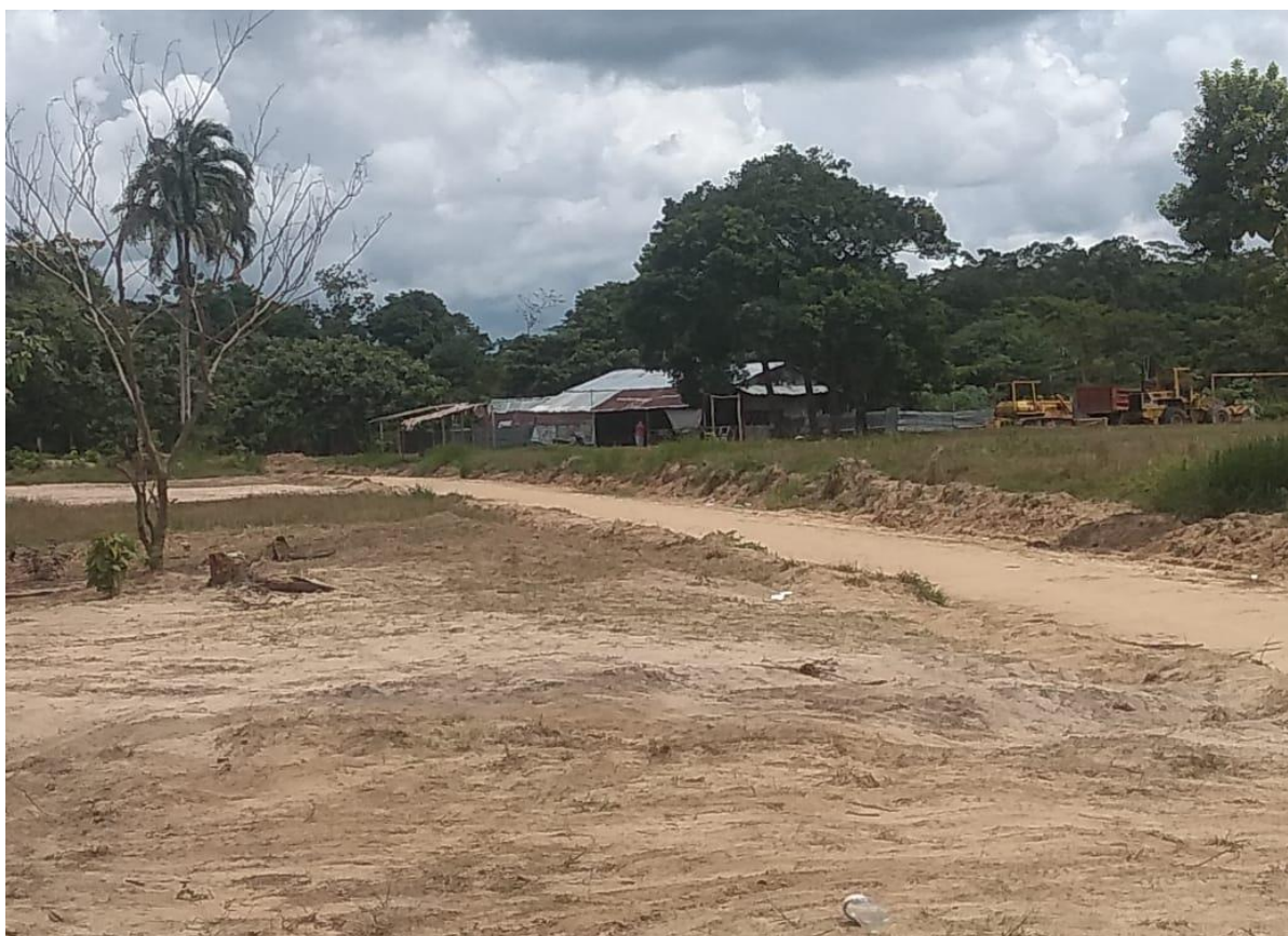
Construcción de carreteras en la comunidad de San Antonio de Picuruyacu
