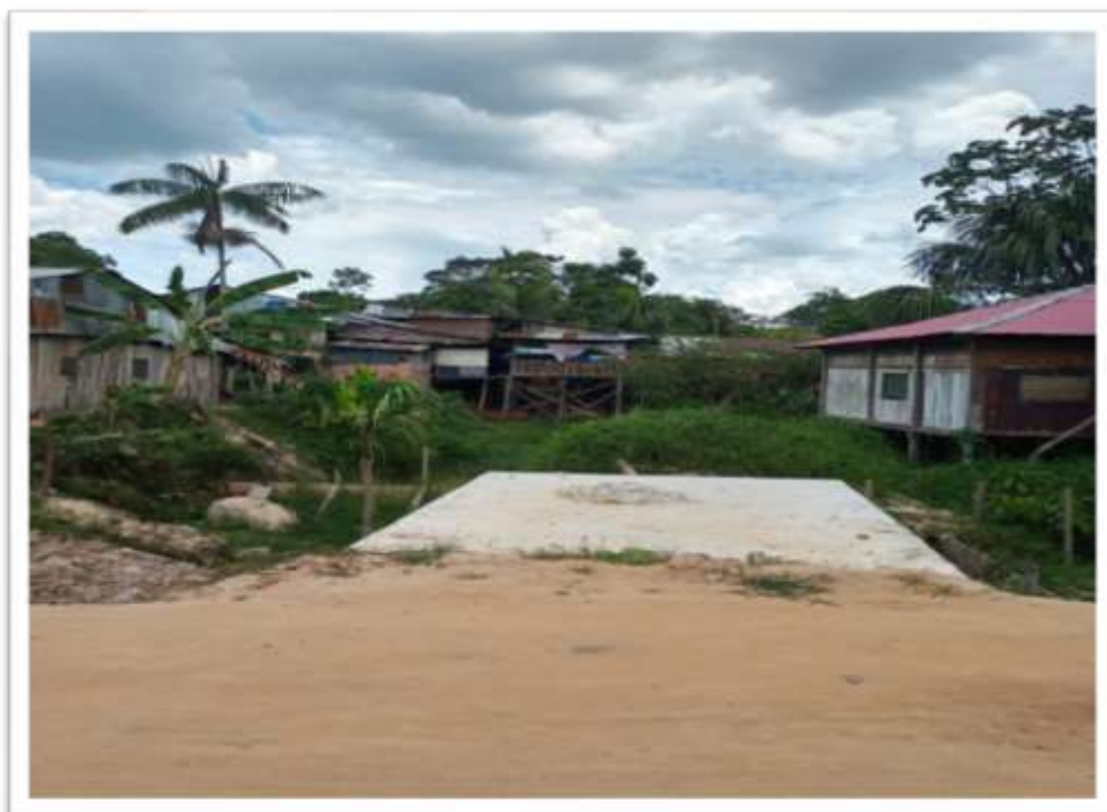
Imagen 3. Construcción del alcantarillado en Santo Tomás.
