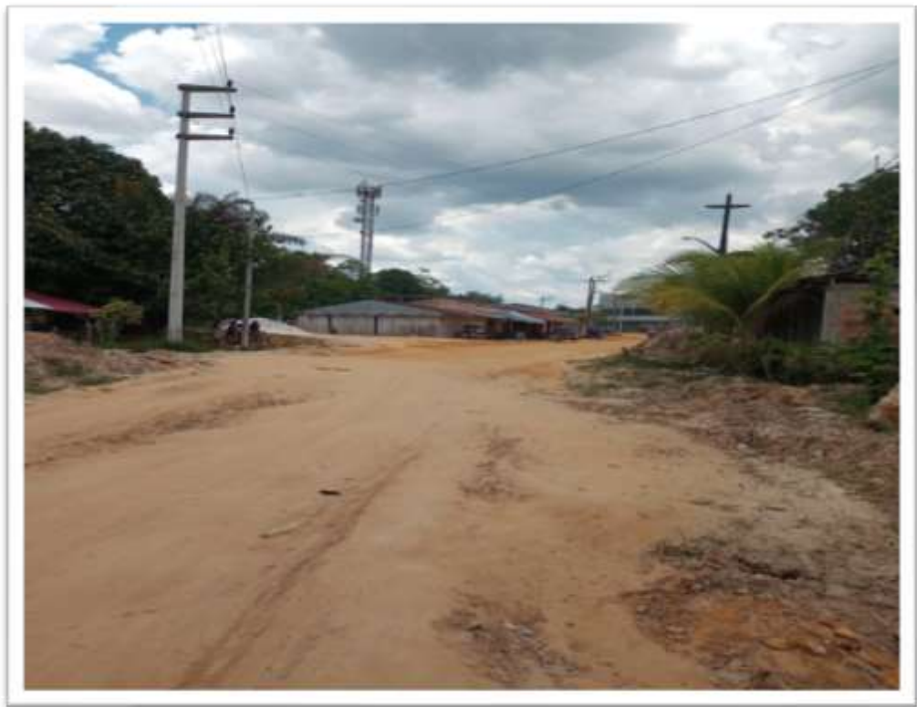
Imagen 2. Estado actual de las calles de Santo Tomás por pavimentación.
