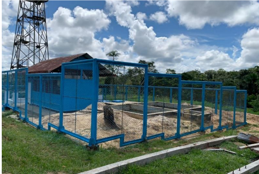
Imagen 1. Planta de tratamiento de agua en el Dorado
