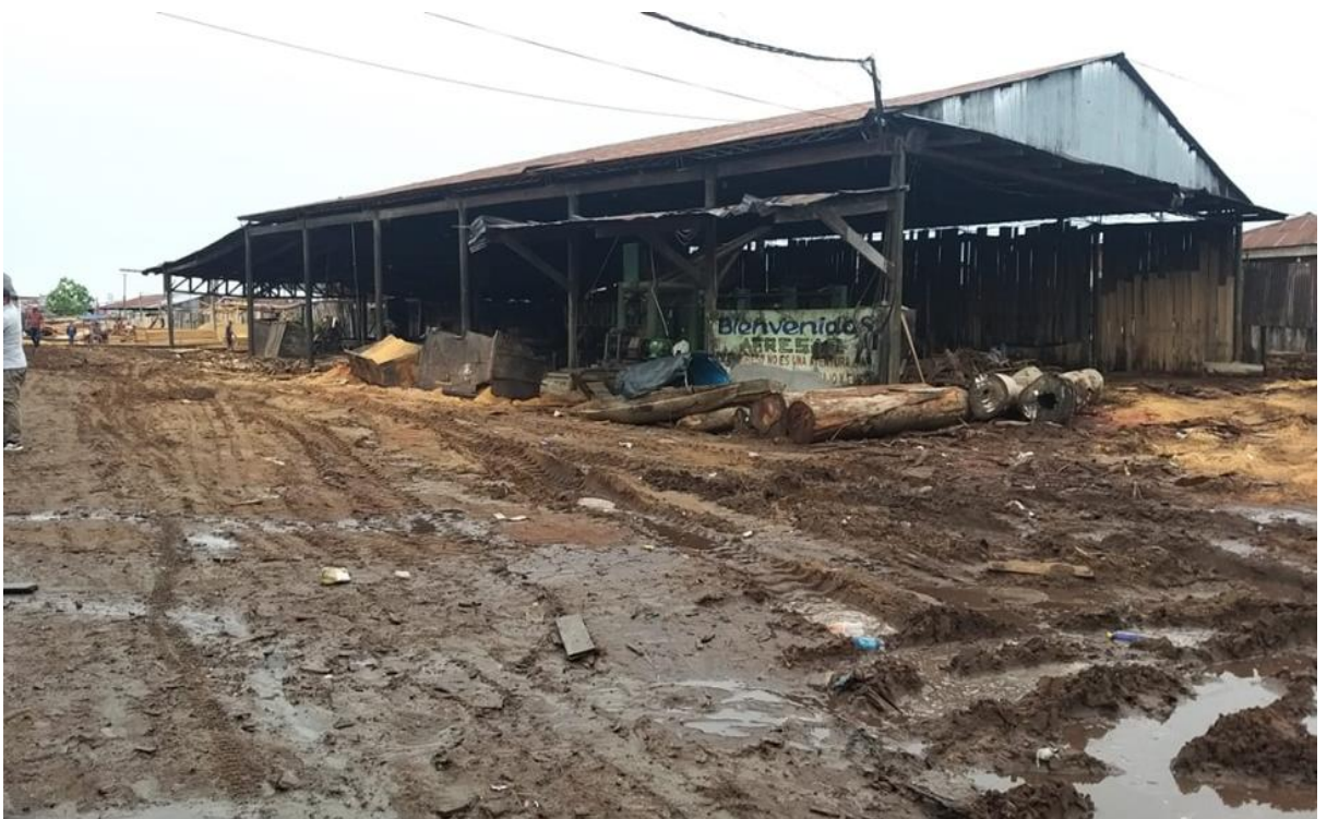
Figura 03: Vista del área afirmada del aserradero de la empresa Forestal Requena
