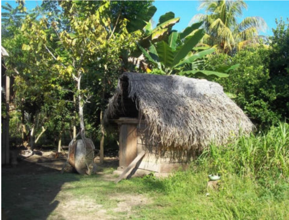
Foto 5. Almacén para acopio de productos.
