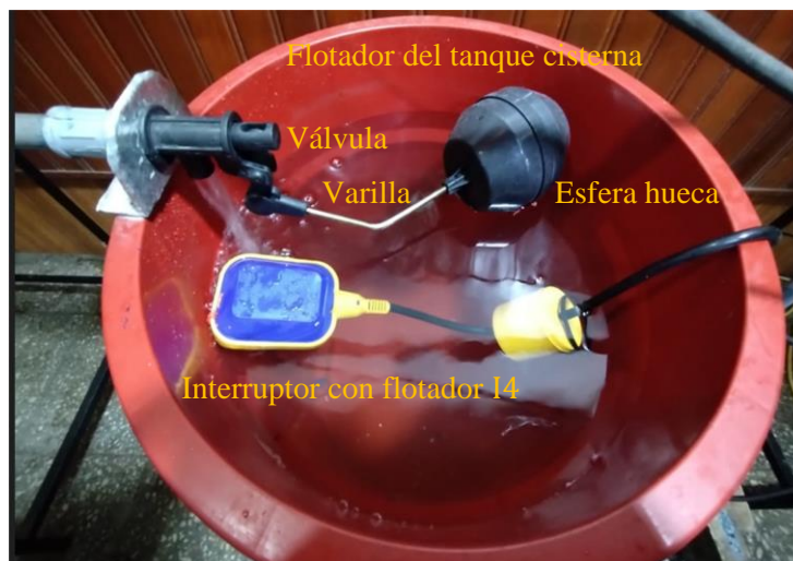
Figura 24. Imagen real del interruptor I4 y del flotador del tanque cisterna.
