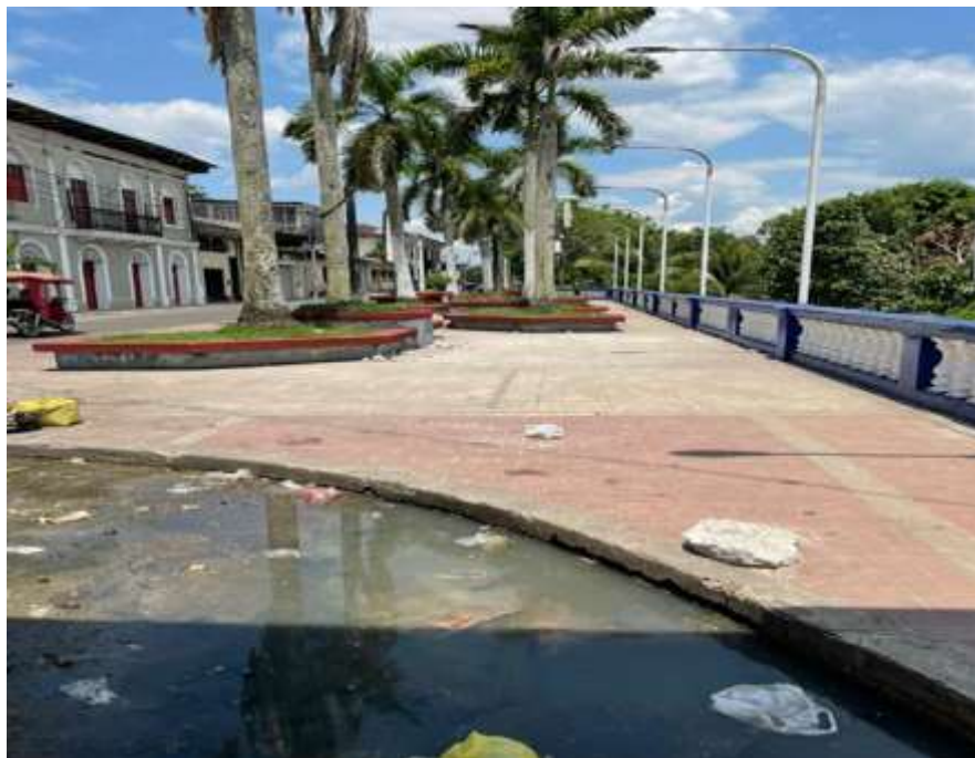
Fotografía (2) del agua: superficial después de una torrencial lluvia queda sobre el suelo pavimentado y con desechos sólidos. (Toma de imagen en octubre 2022).
