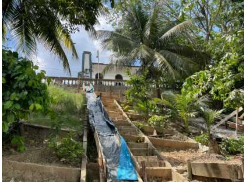
Fotografía (1) del suelo: construcción de escalinatas y forma de terreno. (Toma de imagen en septiembre 2022).
