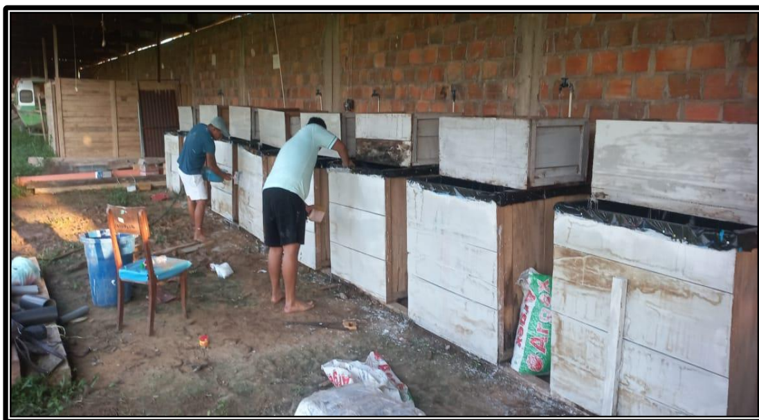
Foto 3. Instalación y acondicionamiento del sistema acuapónico.
