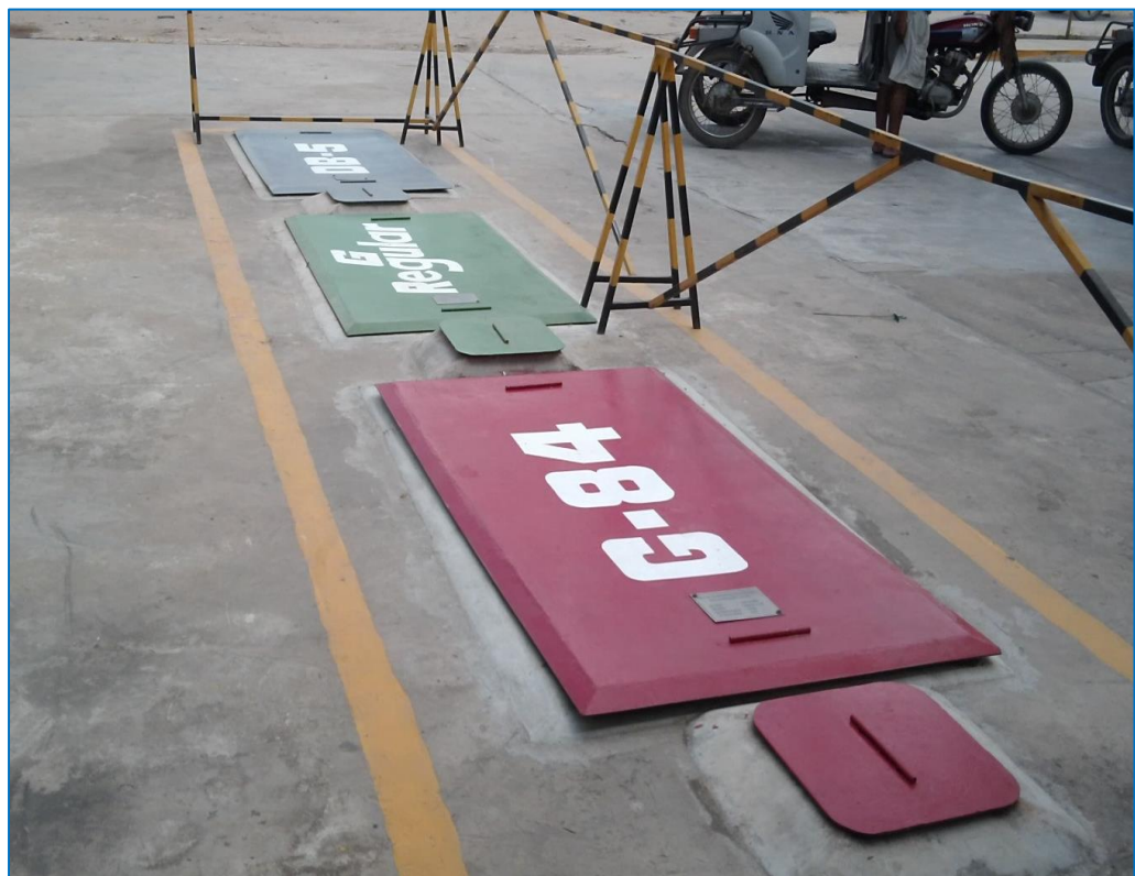
Figura N° 5: Características del tanque de almacenamiento de la segunda estación.
