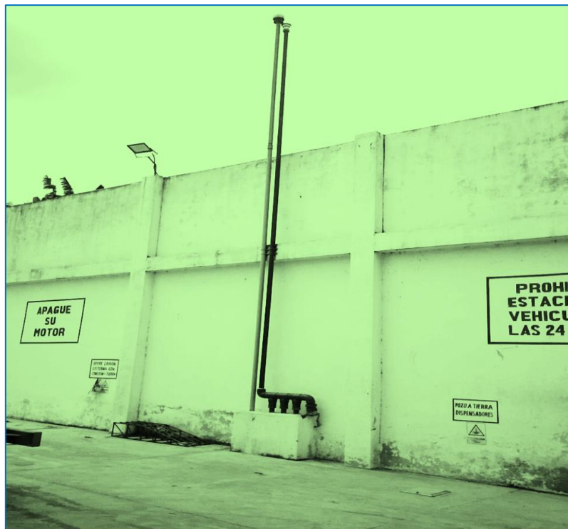
Figura N° 4: Tubo de venteo de la estación con mayor venta.
