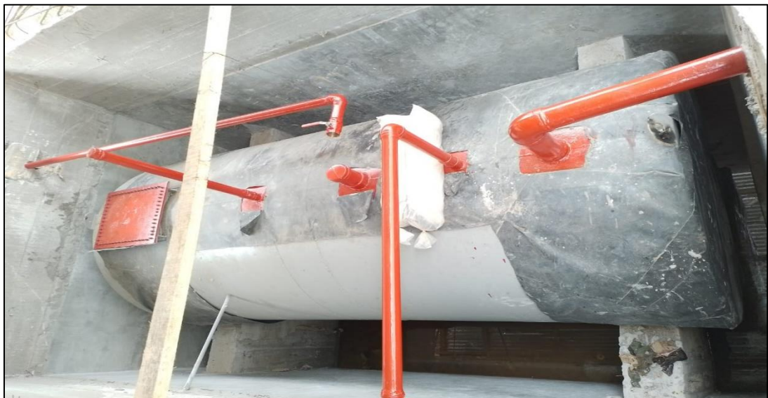
Figura N° 2: Tanques soterrados
