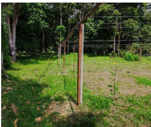
Foto N° 9: Instalación del sistema de conducción en "T"
