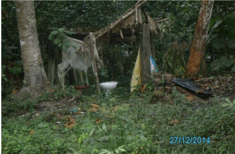
Foto 5. Baño utilizado en algunas casas que no cuentan con desagüe.
