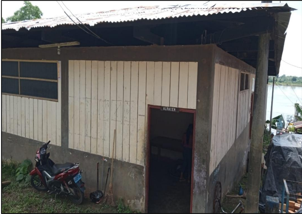
Foto N° 01. Exteriores del almacén
