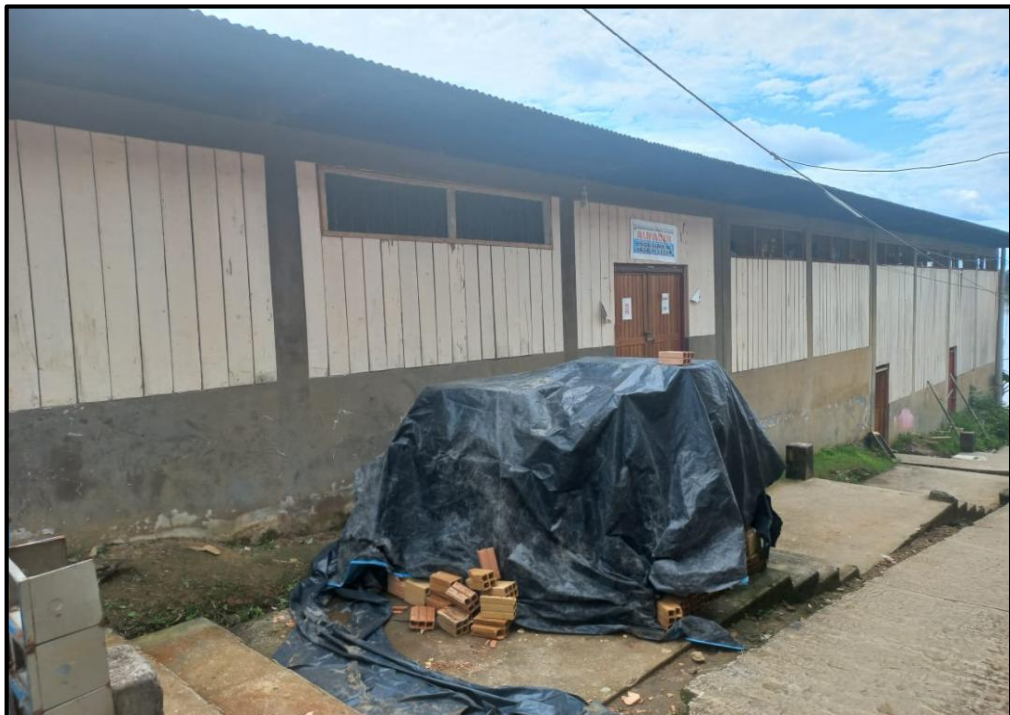
Foto N° 04: Área de almacenamiento de materiales de construcción.
