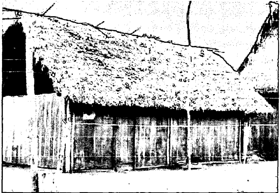
Foto N° 02 Casa techada con Phytelephas macrocarpa .
