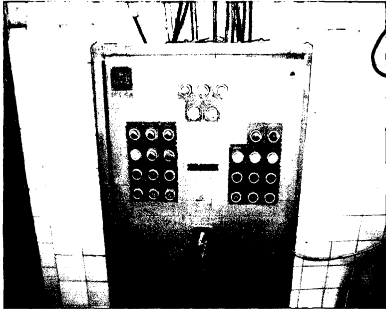
FOTO N° 05: PANEL DE CONTROL DE LA PLANTA
