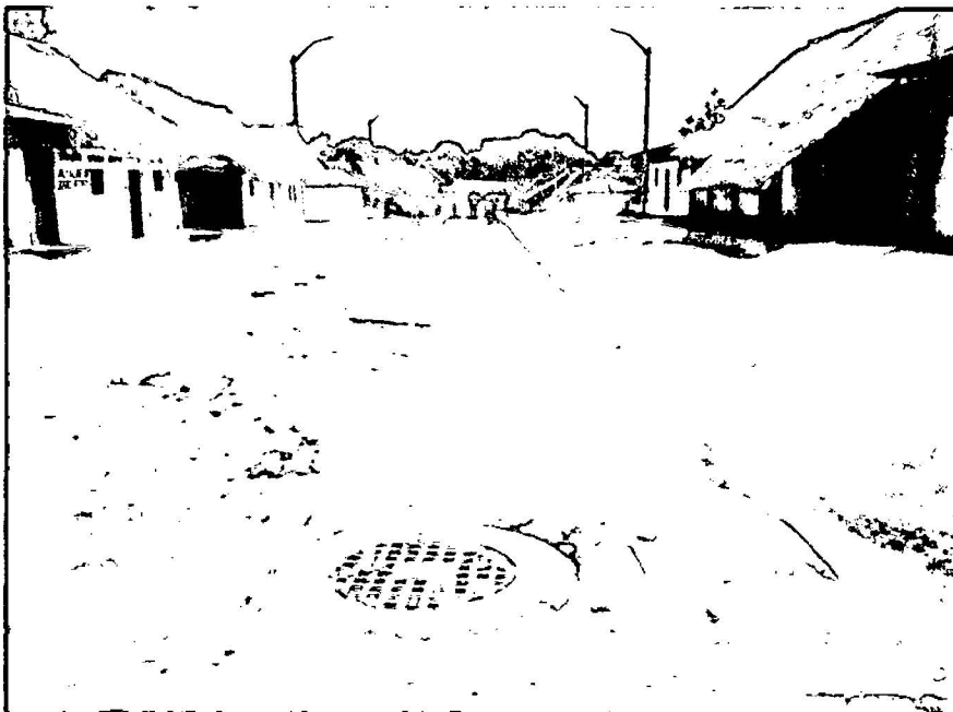
Figura 8: Alcantarillado de la Localidad de Jenaro Herrera.
