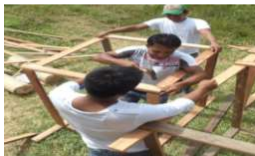
b) Construcción de los cuadrantes para las jaulas
