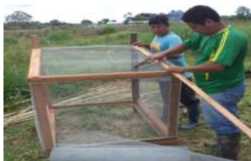
c) Clavado de la malla con ripillas
