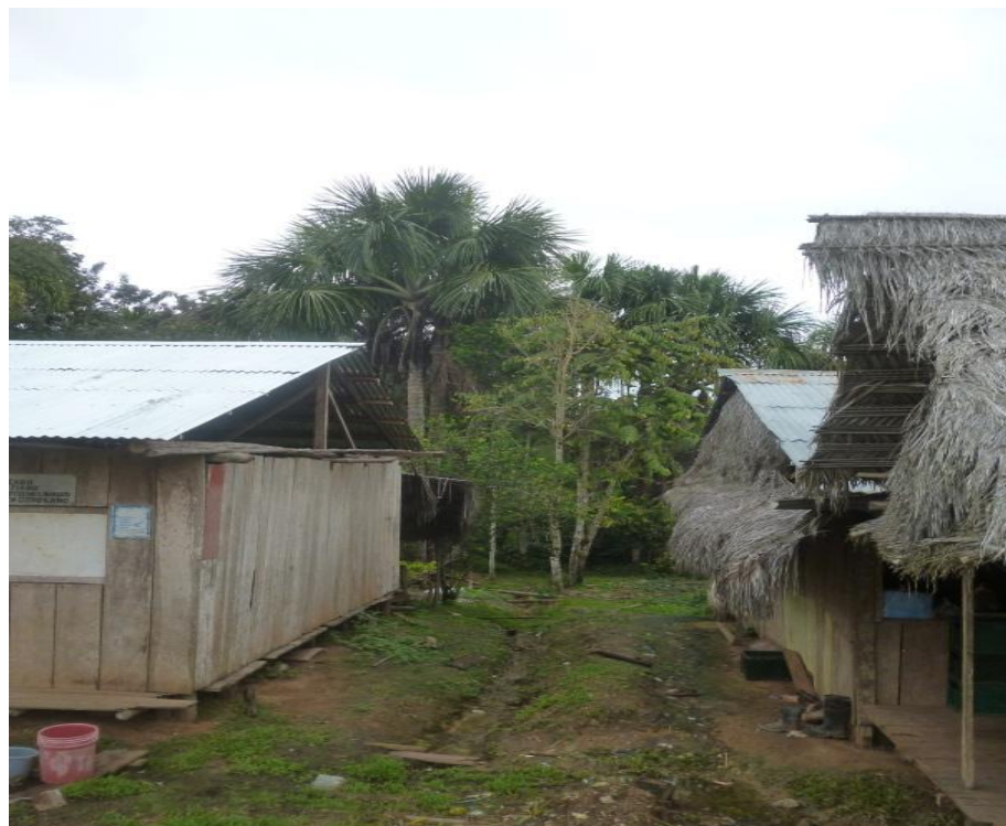
Foto 2. Sistema de drenaje de aguas en Cuyana
