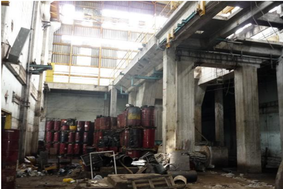
Imagen N° 04. Interior de almacén de residuos peligrosos
