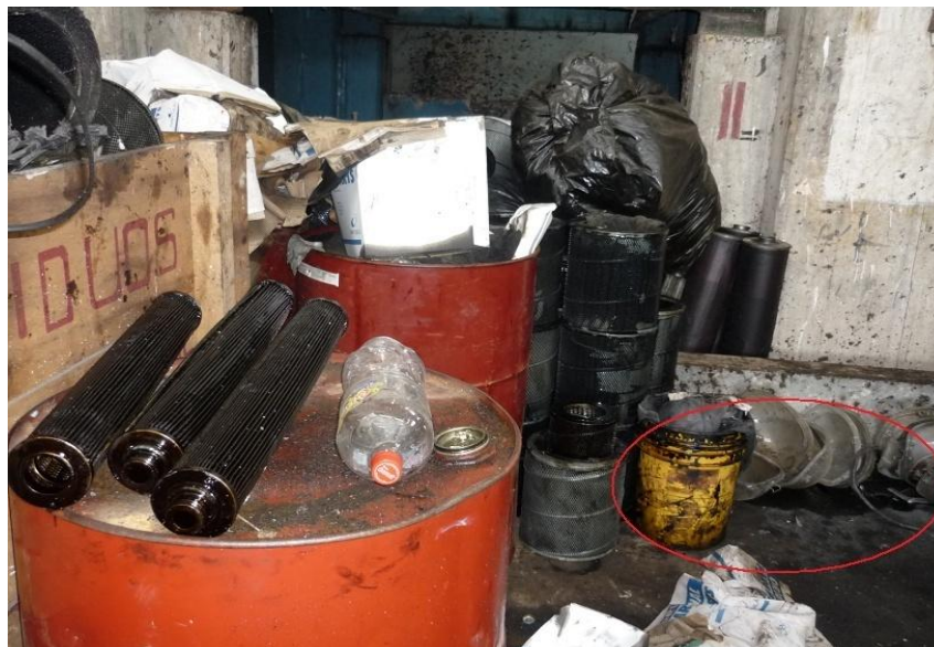
Imagen N° 02. Residuos Peligrosos fuera de área de contención
