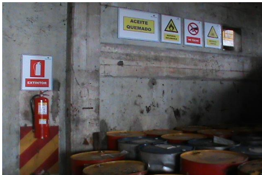
Imagen N° 05. Señalización de áreas de almacenamiento de residuos peligrosos de acuerdo a sus características.
