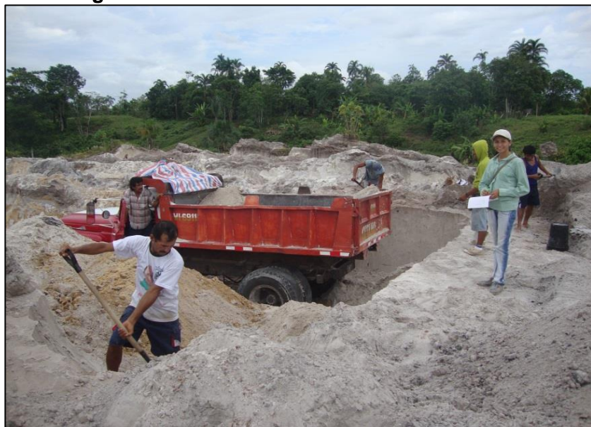
Fotografía N° 04: Forma de extracción manual
