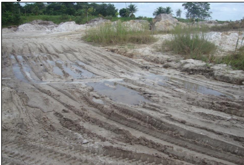
Fotografía N° 10: Daños a las vías de acceso de la comunidad
