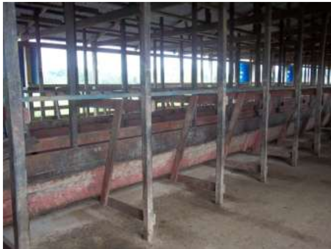
Foto 2. Infraestructura en fundos productores de leche
