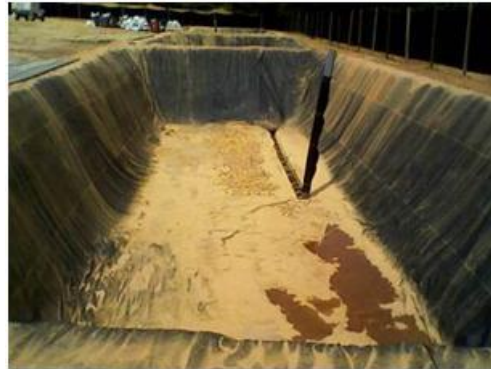
Ilustración 2. Celda con geomembrana
