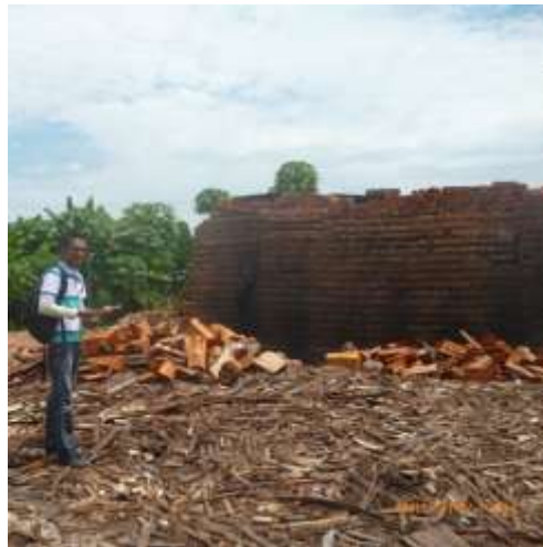
Foto N° 08. Paredes negruzcas por efecto quemado de llantas
