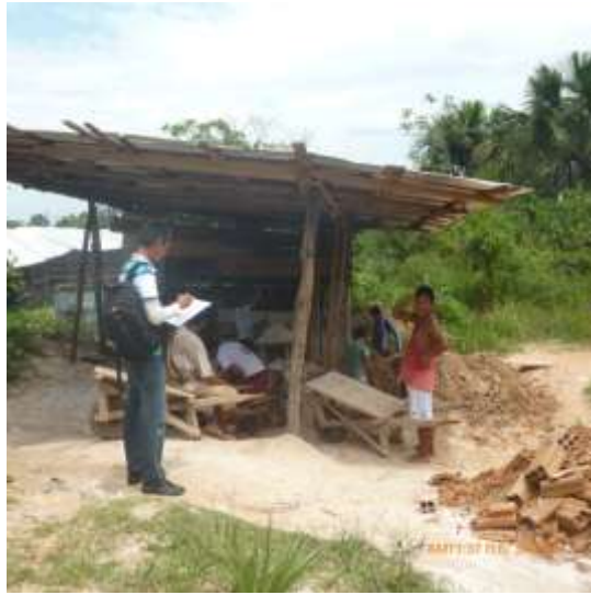
Foto 02. Trabajadores realizando mezcla manual al final de la faena
