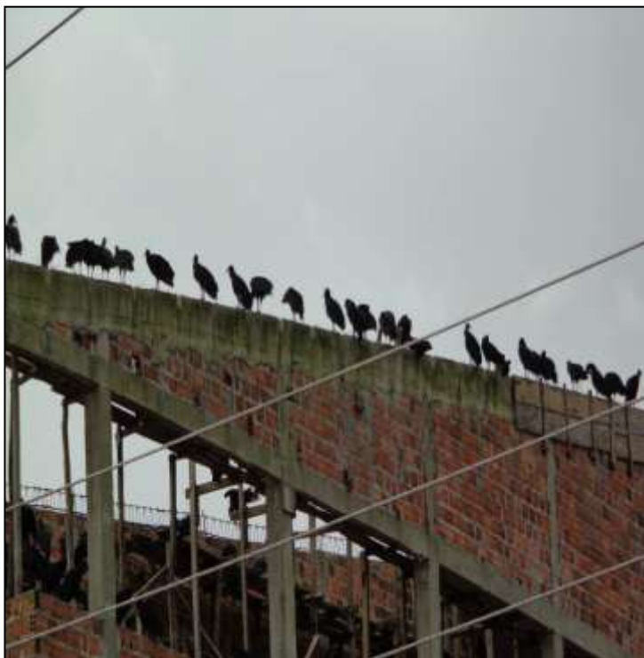
Figura N° 15: Coragyps atratus "Gallinazo" aperchados en una vivienda - Zona Mercado Belén. Zona Baja.
