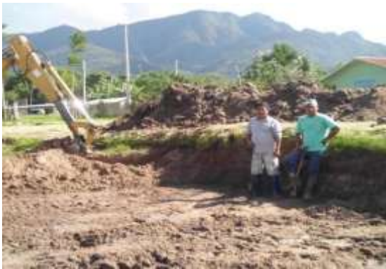
Foto 01 – Construcción del ambiente experimental.
