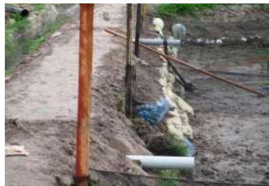
Foto 04 – Estructuras de alimentación de agua.
