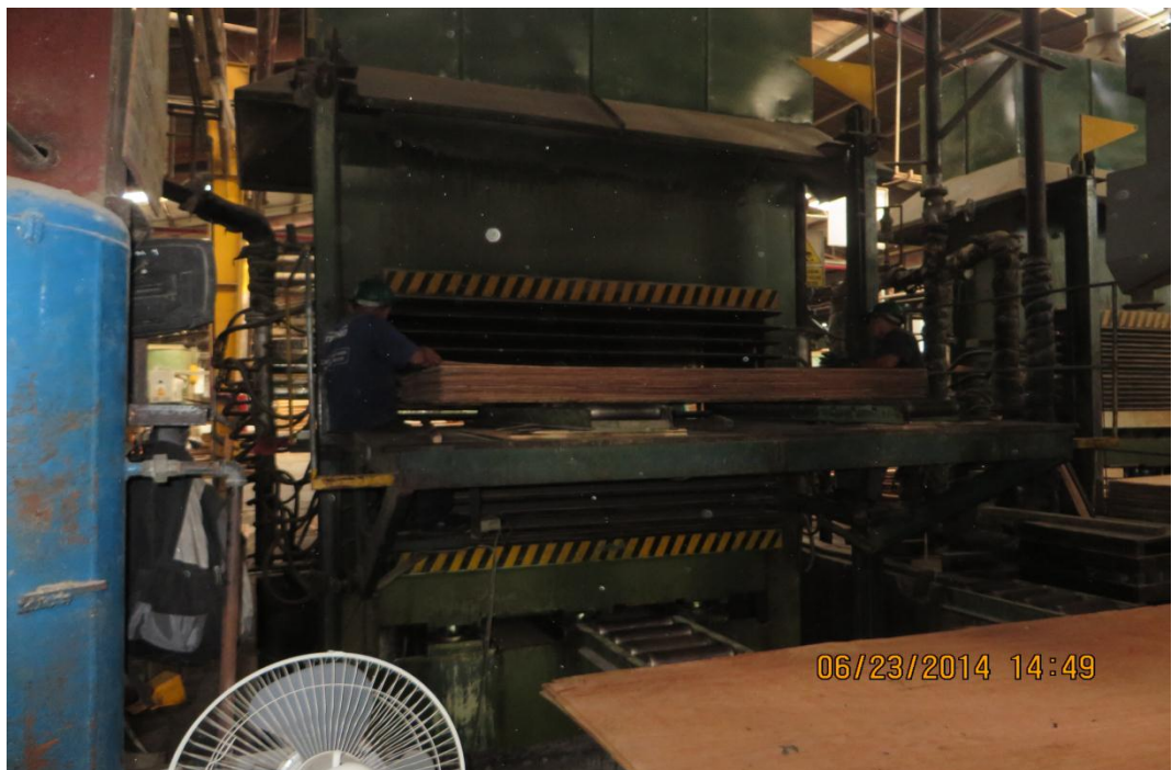
Figura N°24 : Ingreso de las planchas armadas en la prensa caliente.
