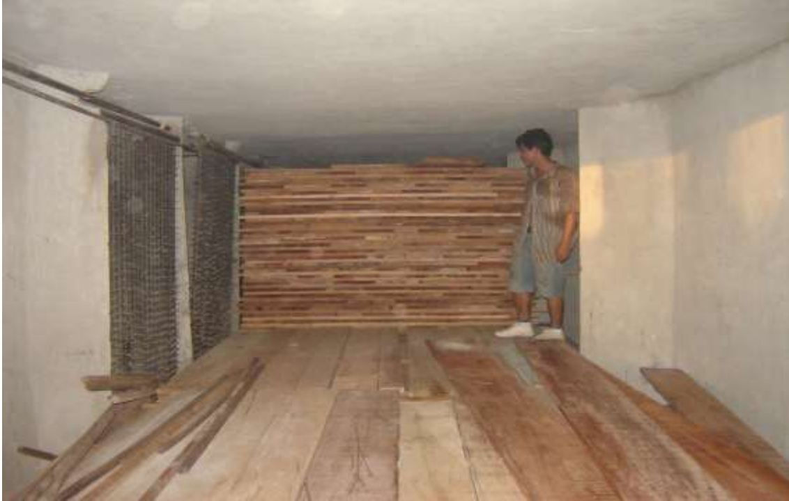
Figura 11: Cámara en proceso de llenado
