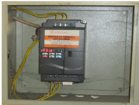
Imagen N° 06. Variador de velocidad de aire en secador de lecho fluidizado.
