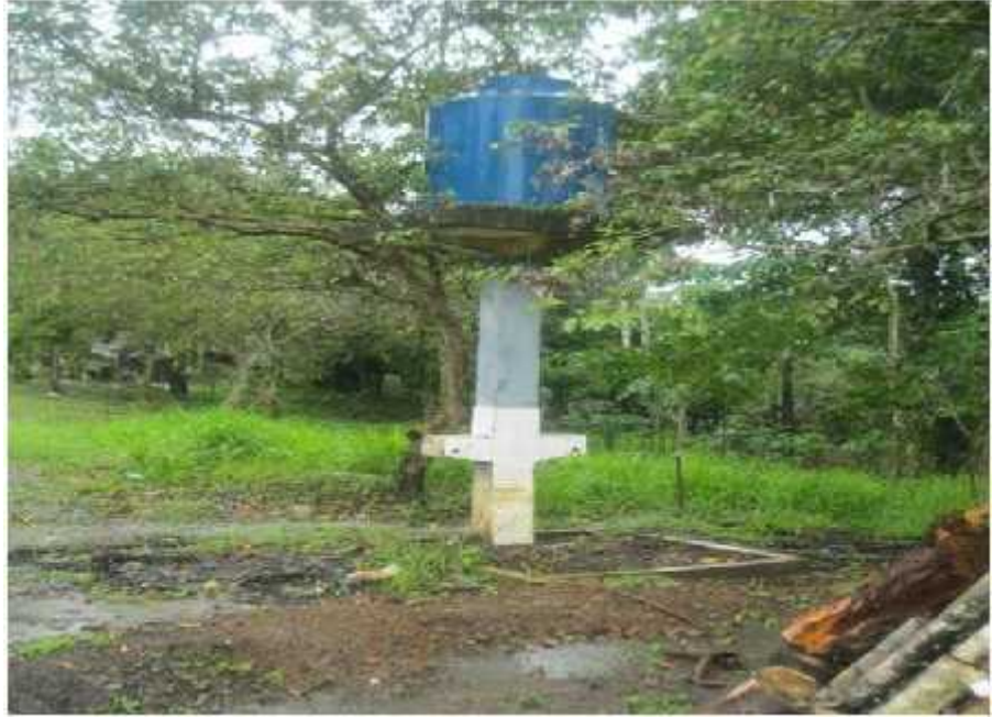
Foto 8. Tanque elevado. Ullpa caño
