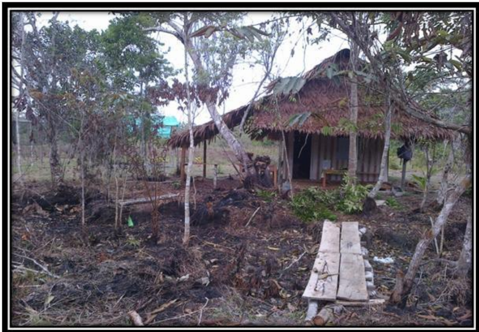
Imagen 8: CONSTRUCCION DEL ALMACEN PARA LOS MATERIALES
