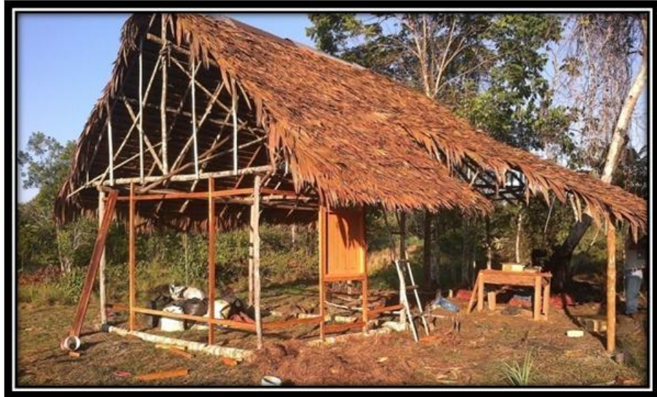
Imagen 7: CONSTRUCCION DEL ALMACEN PARA LOS MATERIALES
