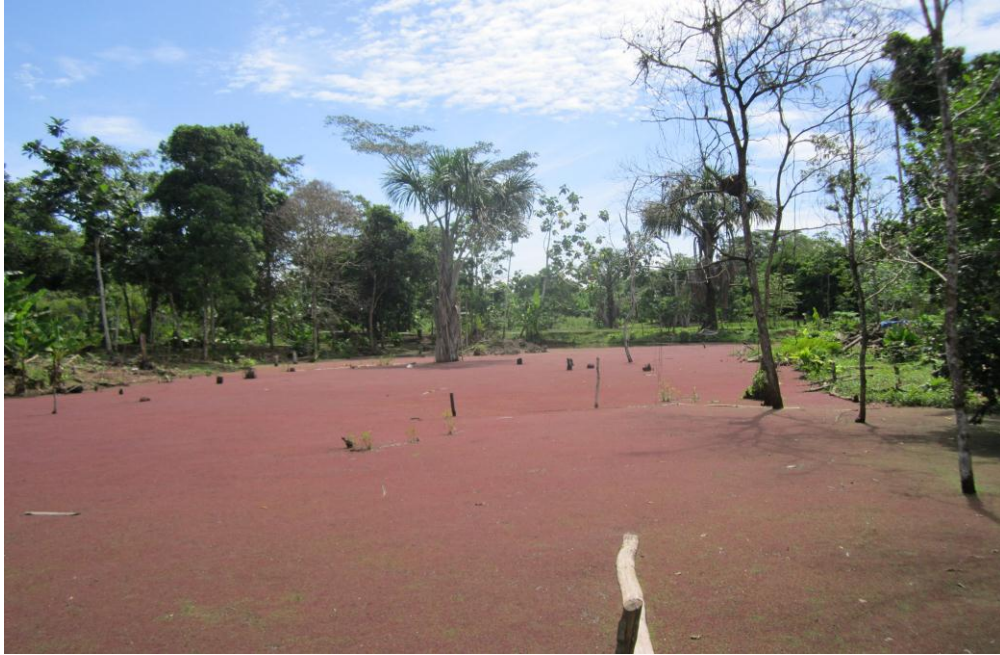
Foto 4. Piscigranjas en etapa de construcción.
