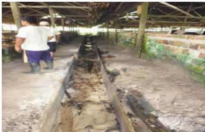
FOTO N° 06. Recolector dentro las instalaciones
