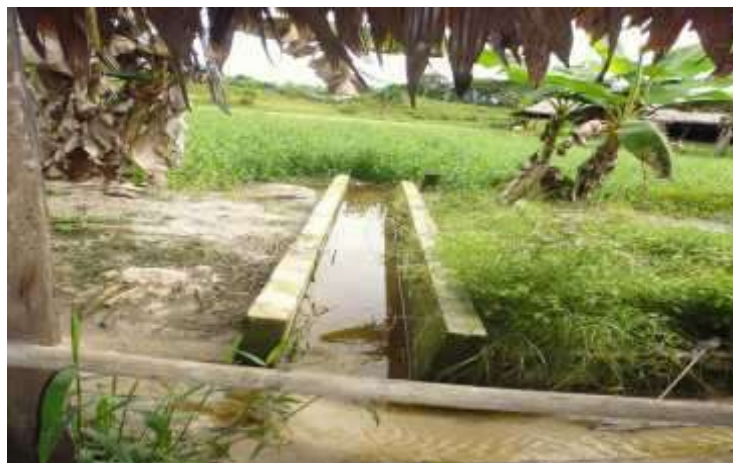
FOTO N° 09. Recolector que conecta a la laguna de oxidación
