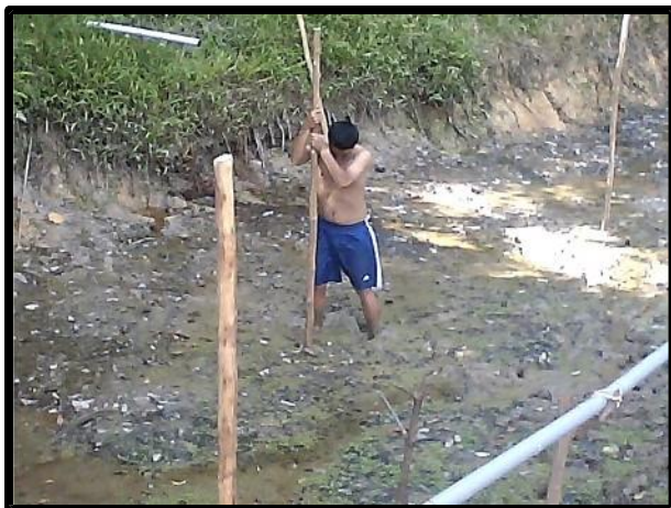
Foto N°3 Construcción de los corrales
