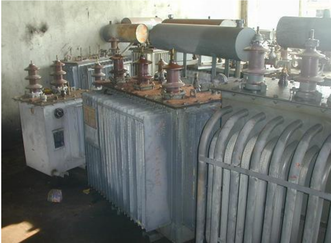
Fotografía 13: Transformadores malogrados almacenados para su eventual disposición final, en su interior con aceite dieléctrico
