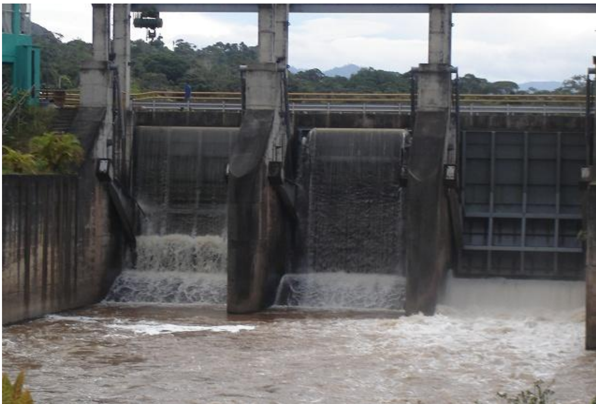
Fotografía 06: Central Hidroeléctrica Gera – Moyobamba
