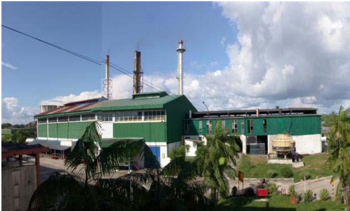
Fotografía 01: Vista frontal de la Central Termoelectrica Electro Oriente S.A.
