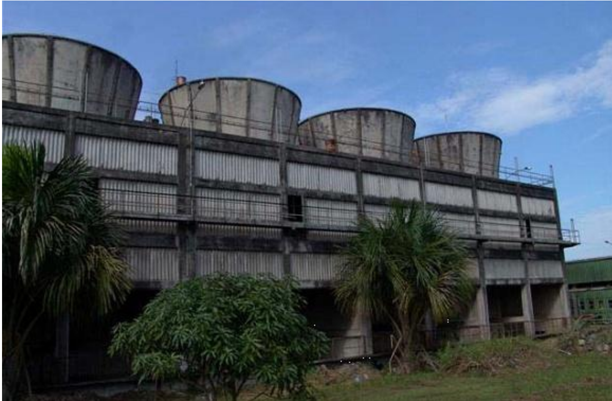
Fotografía 05: Antiguas instalaciones Skoda, con paredes revestidas de Asbesto en deterioro
