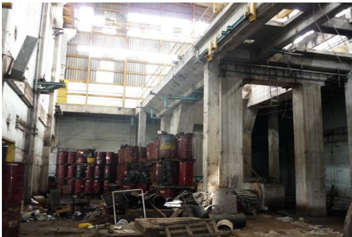
Fotografía 02: Interior del Almacén provisional de Residuos en Electro Oriente S.A. – Iquitos
