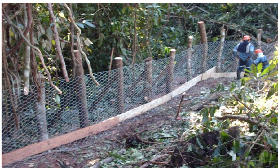
Foto 2. Construcción de una trinchera de malla de metal tipo A de 1,50 m de alto x 15 m de ancho. (22,5 m<sup>2</sup>)
