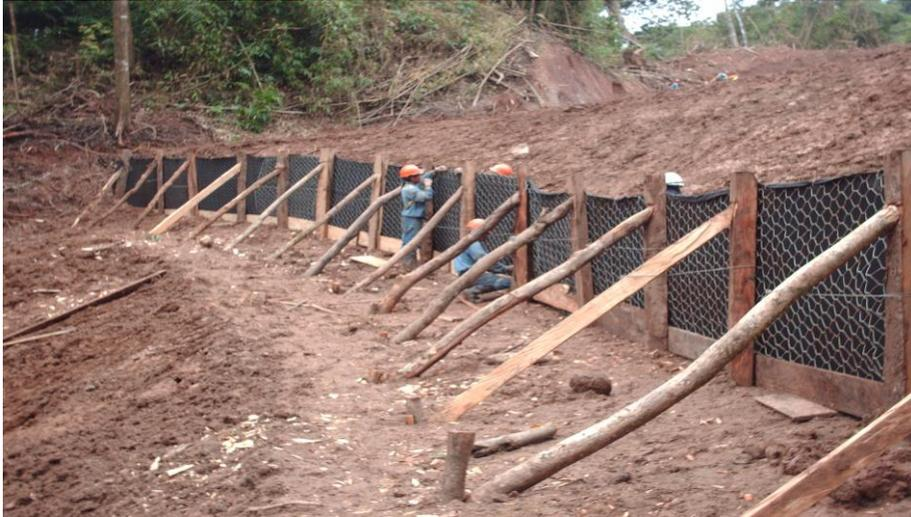
Foto 3. Construcción de una trinchera de malla tipo A de metal de 1,50 m de alto x 15 m de ancho. Con doble torsión. (22,5 m<sup>2</sup>)
