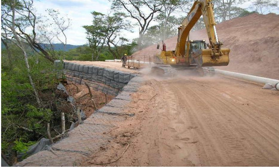
Foto 9. Muro de gaviones de suelo 5 m x 80 m (400 m<sup>2</sup>)
