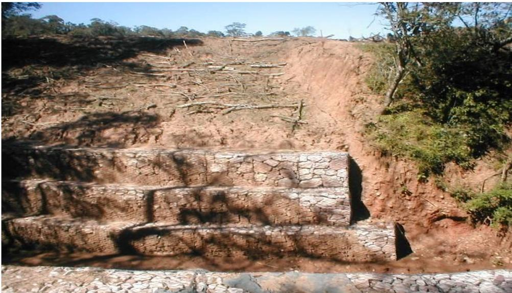
Foto 8 Muros de gaviones de piedra. 4,5 m x 50 m (225 m<sup>2</sup>)
