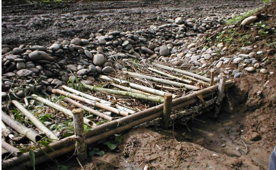
Foto 11. Estructuras de drenaje tipo saltos. 4,5 x 20 m (90 m<sup>2</sup>)
