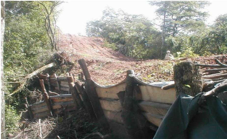
Foto 4. Construcción de una trinchera de madera tipo B de metal de 1,50 m de alto x 15 m de ancho. (22,5 m<sup>2</sup>)
