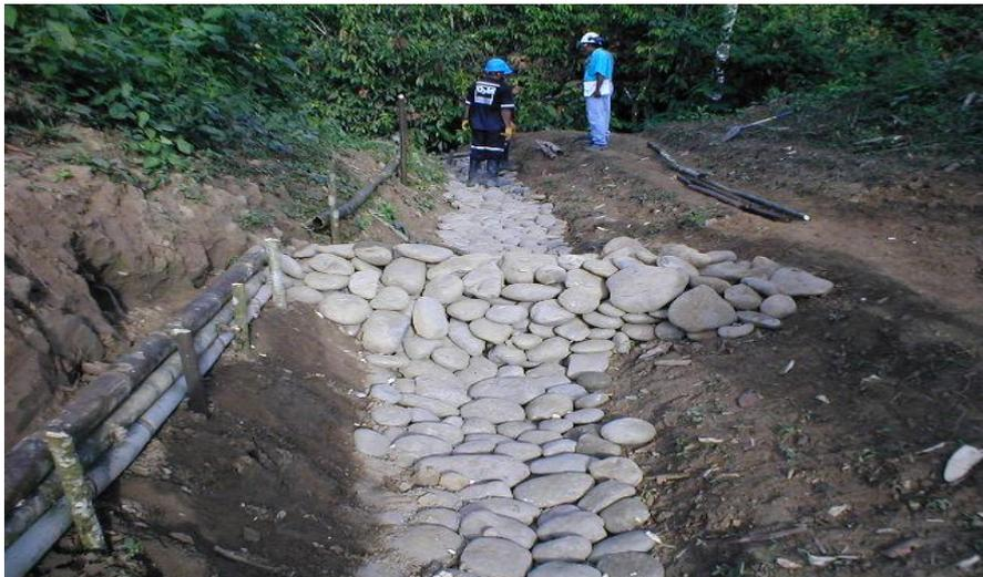
Foto 12. Estructuras de drenaje tipo saltos
