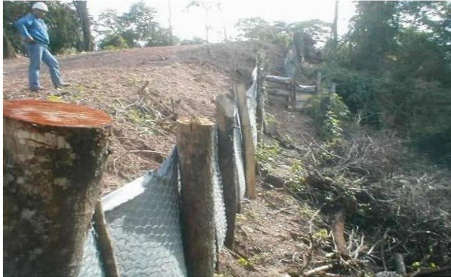
Foto 5. Construcción de una trinchera de madera tipo C de metal de 1,50 m de alto x 150 m de ancho. (22,5 m<sup>2</sup>)
