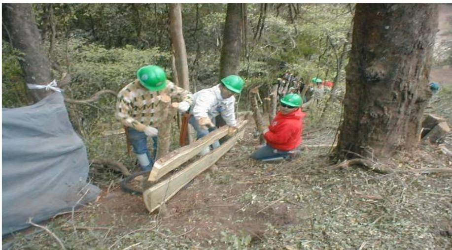
Foto 1. Construcción de trincheras de madera, tipo A de 1,50 m de alto x 15 m de ancho. (22,5 m<sup>2</sup>)
