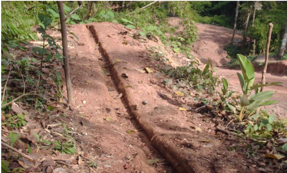
Foto 10. Canales revestidos con biomanta. 0,25 m x 50 m (1,25 m<sup>2</sup>)
