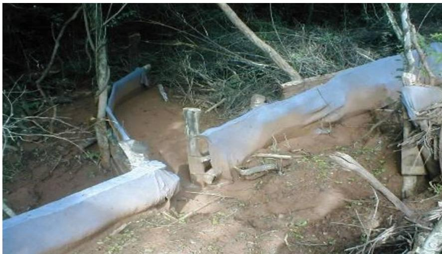
Foto 13. Estructura de descarga Trinchera canal. 10 m x 1,5 (15 m<sup>2</sup>)
