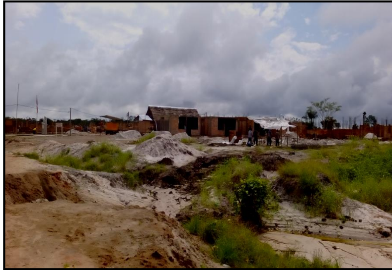
Foto N° 05: Inicios de la obra de construcción de viviendas
