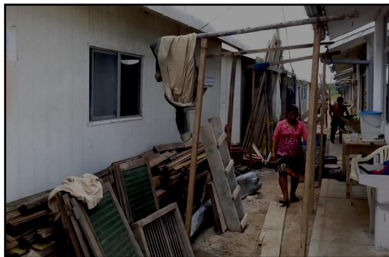
Foto N° 02. Módulos de vivienda prefabricados
