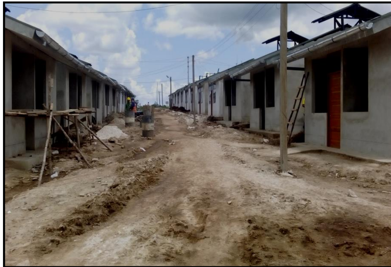
Foto N° 06: Primer lote de viviendas casi culminadas
