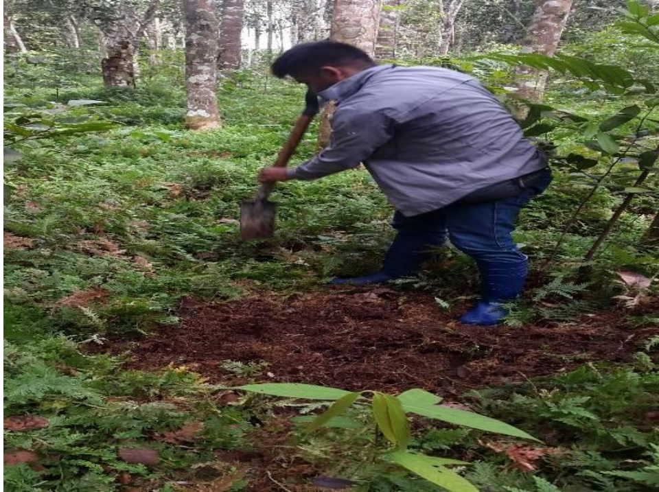
Fig. 17: Limpieza del suelo para formar la calicata
