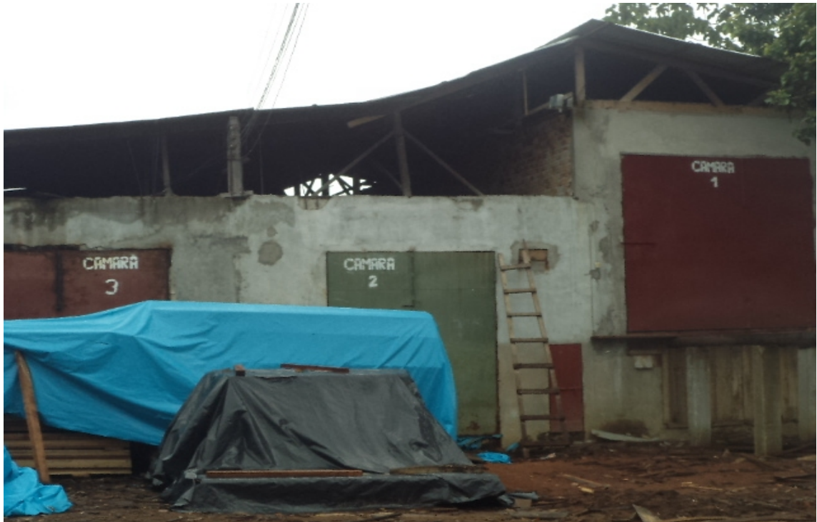
Figura N°17. Cámaras de secado e la empresa Sico Maderas SAC.
