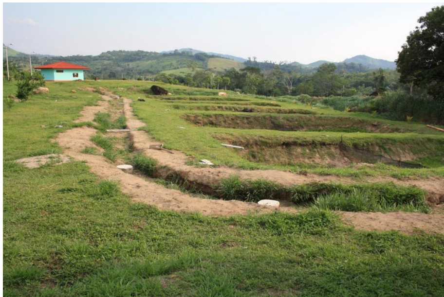
Foto N° 1: Área de ejecución (5 estanques de 200 m 2 ).
