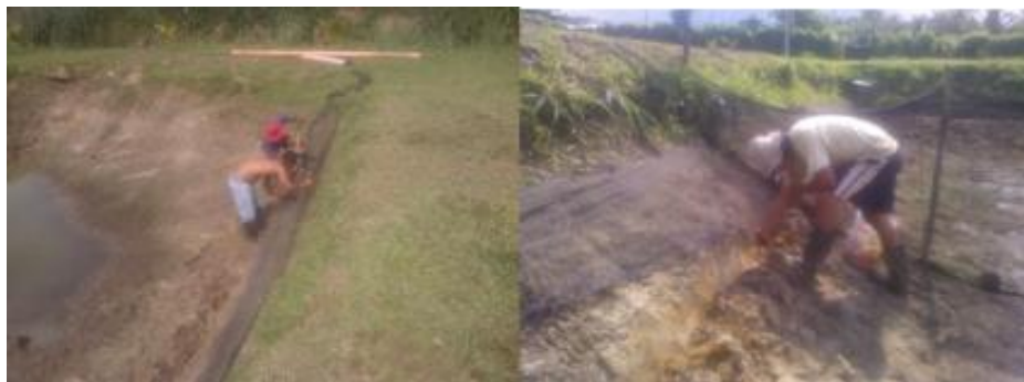
Foto N° 7: Enmallado de estanques.
