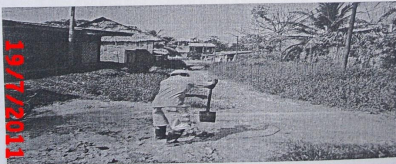
VISTA FOTOGRAFICA DONDE SE APRECIA LA LIMPIEZA DEL TERRENO
