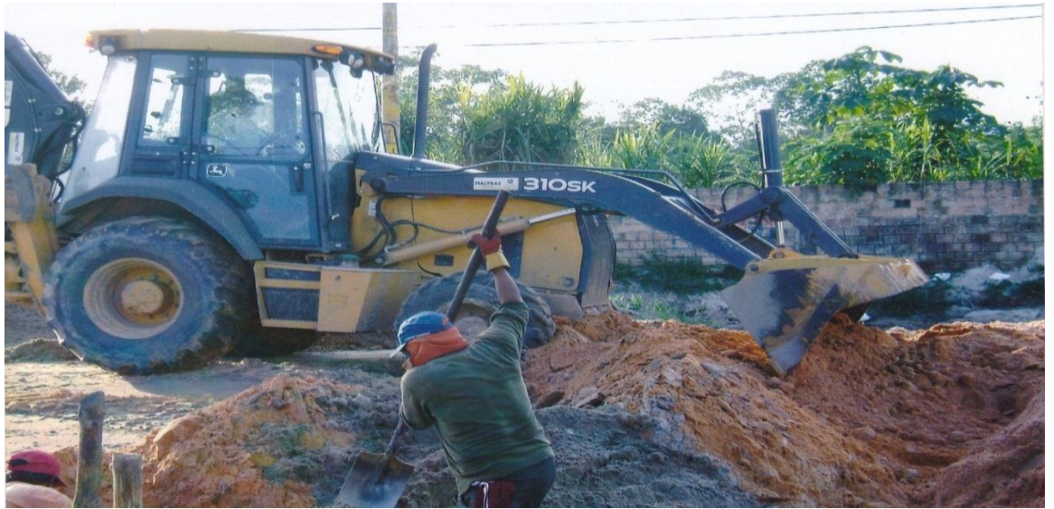
Fotografía N° 11 Trabajos en ejecución de la obra del término del proyecto del alcantarillado calle corpac-año 2014.
