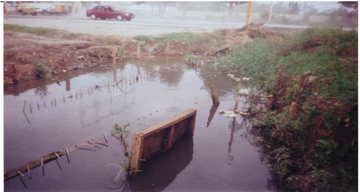
Fotografía N° 7 Vista n° 1 de la pista inundada por aguas servidas derramadas por el alcantarillado inconcluso.
