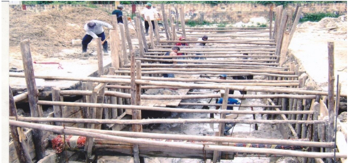
Fotografía N° 10 Construcción en ejecución para el ducto terminal del proyecto del alcantarillado calle corpac- año 2014.
