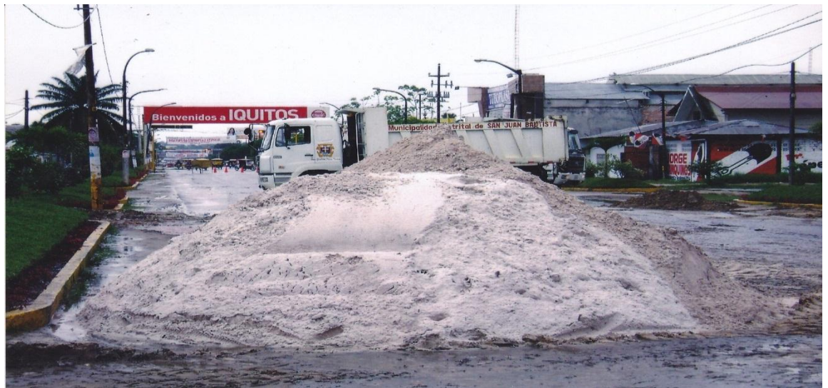
Fotografía N° 12 Trabajos en ejecución de la obra del término del proyecto del Alcantarillado calle corpac-año 2014.
