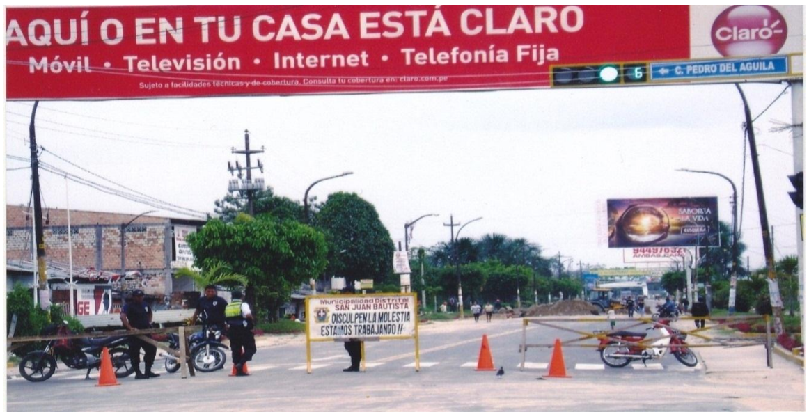
Fotografía N° 9 AV. Quiñones interrumpida para efectuar trabajos continuación del proyecto del alcantarillado corpac - año 2014.
