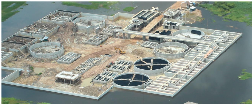
Foto 02 Vista aérea 2012. Construcción de los tanques de oxidación y percoladores
