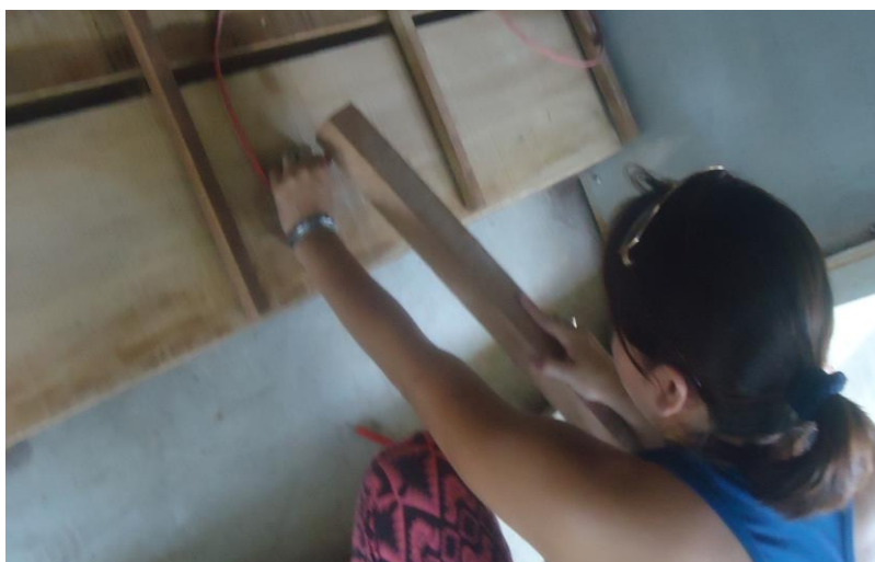
Figura 9. Colocación de sensores de control de contenido de humedad
