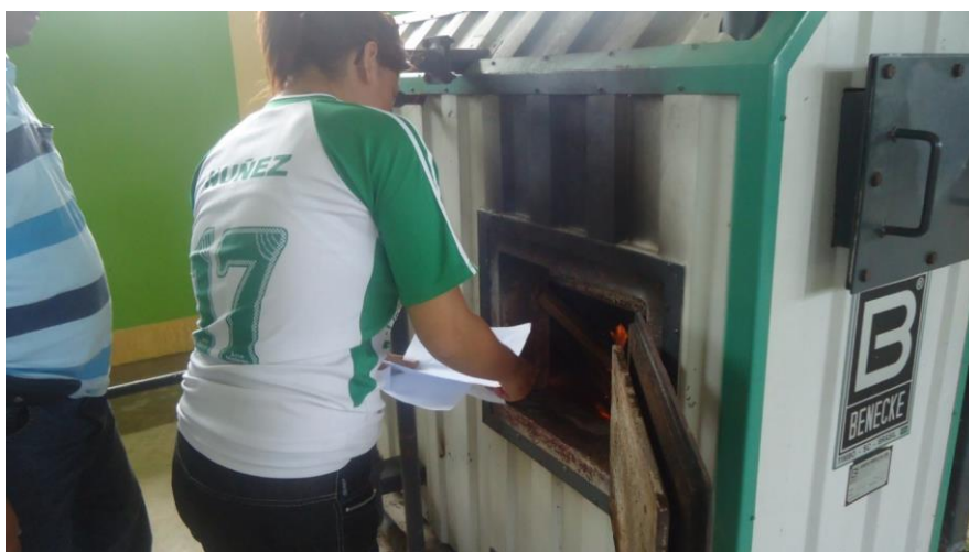
Figura 12. Encendido del caldero de agua caliente
