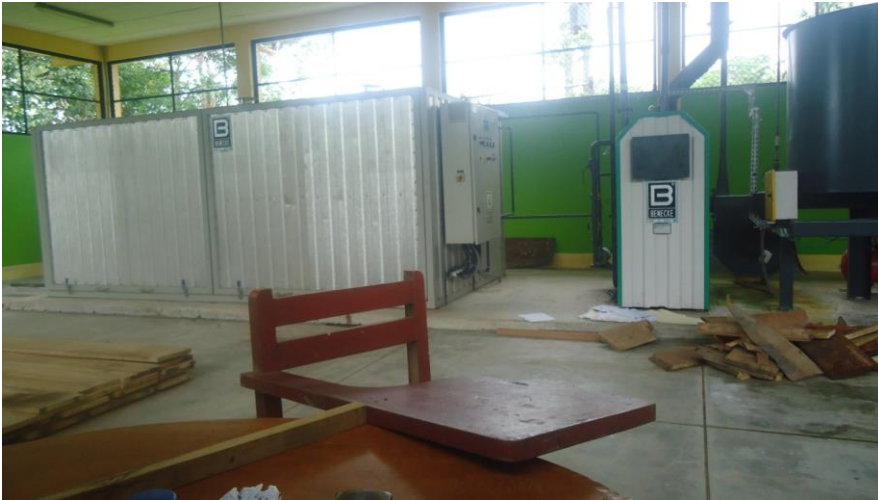
Figura 13. Vista panorámica de la cámara de secado, caldero de agua caliente y dosificador de biomasa
