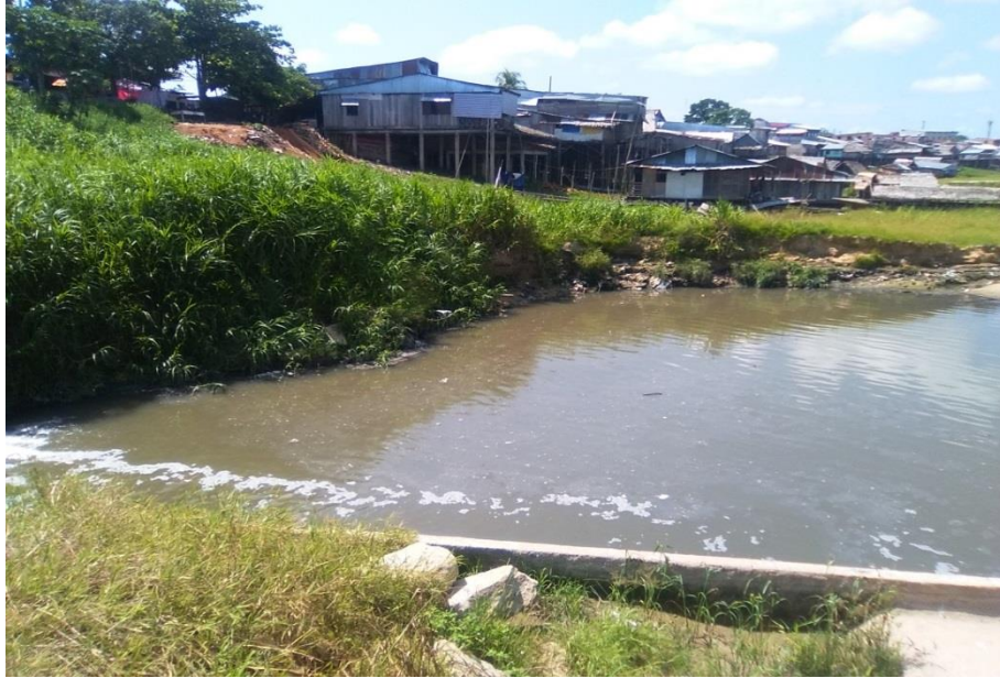
Foto 01. Colector de la Avenida Mariscal Cáceres.
