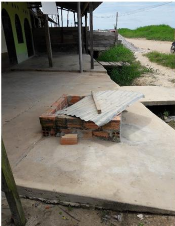
Imagen 04. Pozo cerrado en concreto en una vereda cerca a caída de agua, nótese cerca del pozo el desagüe común de la población
