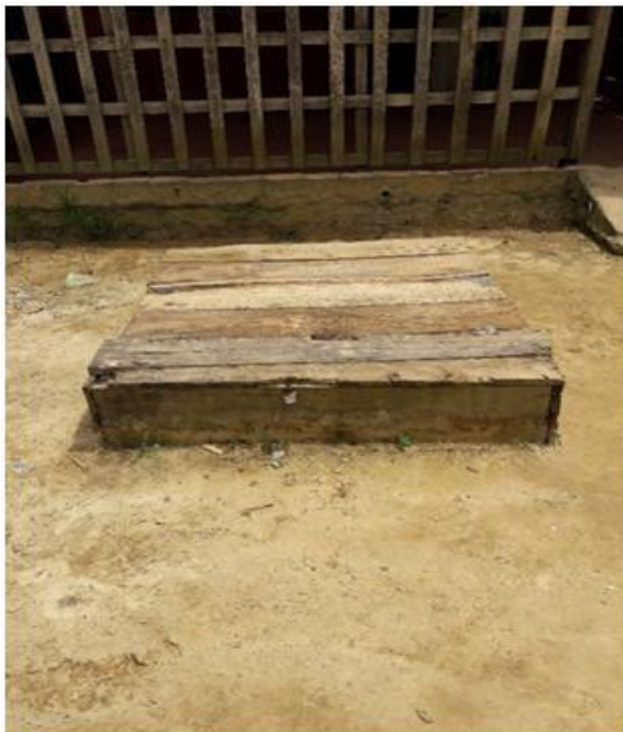
Imagen 06. Pozo con tapa a pie de calle, con los mismos problemas que los pozos anteriores.
