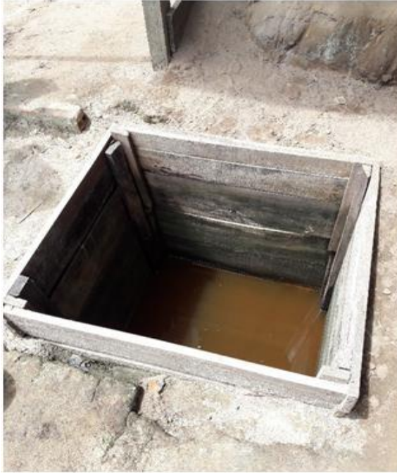
Imagen 05. Pozo a cielo abierto de 1m x 1m de, con base de madera y cuya agua se acumula producto de la lluvia con muy bajo contenido producto de afloramiento superficial, agua usada solo para bañarse y lavar ropa.
