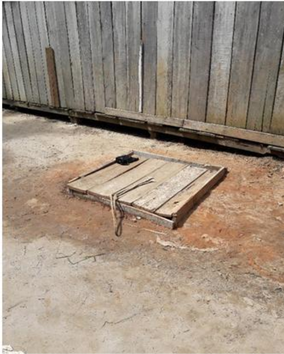
Imagen 03. Pozo pequeño y bajo con zonas encharcadas en las zonas laterales, lo que genera contaminación.
