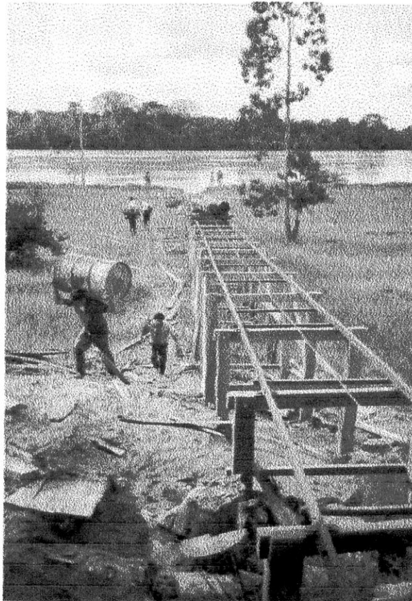
Figura 02. Plataforma de Transporte de Trozas del Puerto al Aserradero Santa Mercedes
