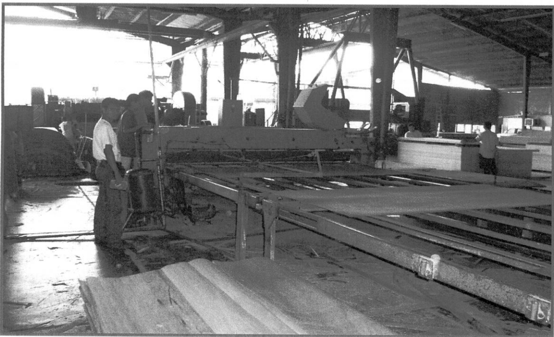
Foto N° 14: Obtención de láminas húmedas en la cizalla.
