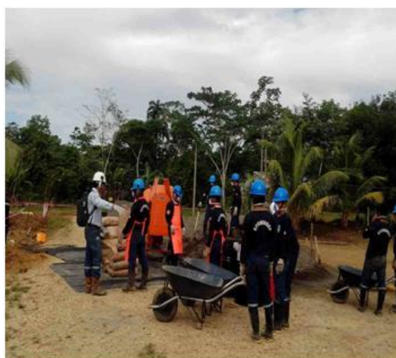
Imagen 03. Personal en trabajo de preparación de mortero
