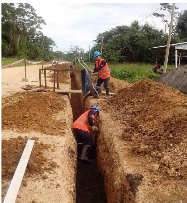
Imagen 04. Personal de apoyo local realizando zanjas en la comunidad
